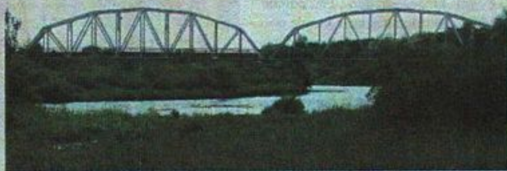
PKP zapowiadają budowę nowego mostu kolejowego w Warce. Czy stary stanie się tylko atrakcją turystyczną?
