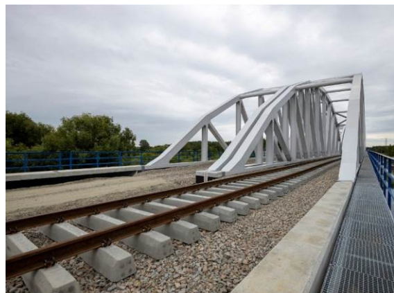
Most kolejowy na rzece Pilicy
