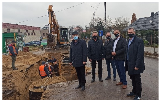
Warka ul. Turystyczna
