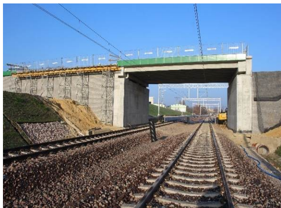
Warka ul. Lotników – Wiadukt
